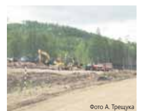
Фото А. Трещука
