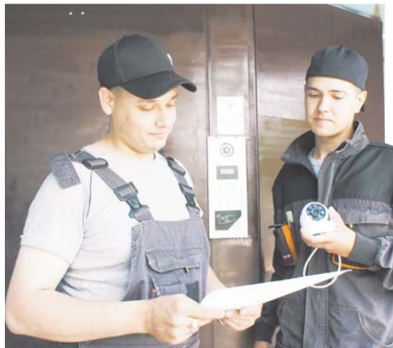
Монтажники Евгений Подгрушин (слева) и Михаил Лаврик. Перед установкой камеры видеонаблюдения нелишне ещё раз заглянуть в схему
