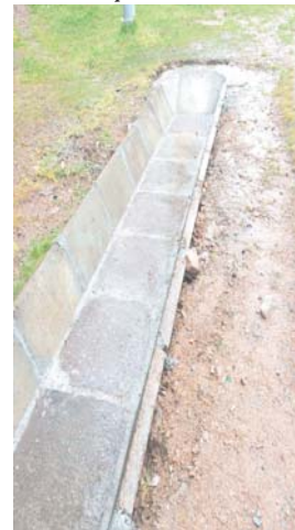
Водосточная канава, куда не стекает вода
