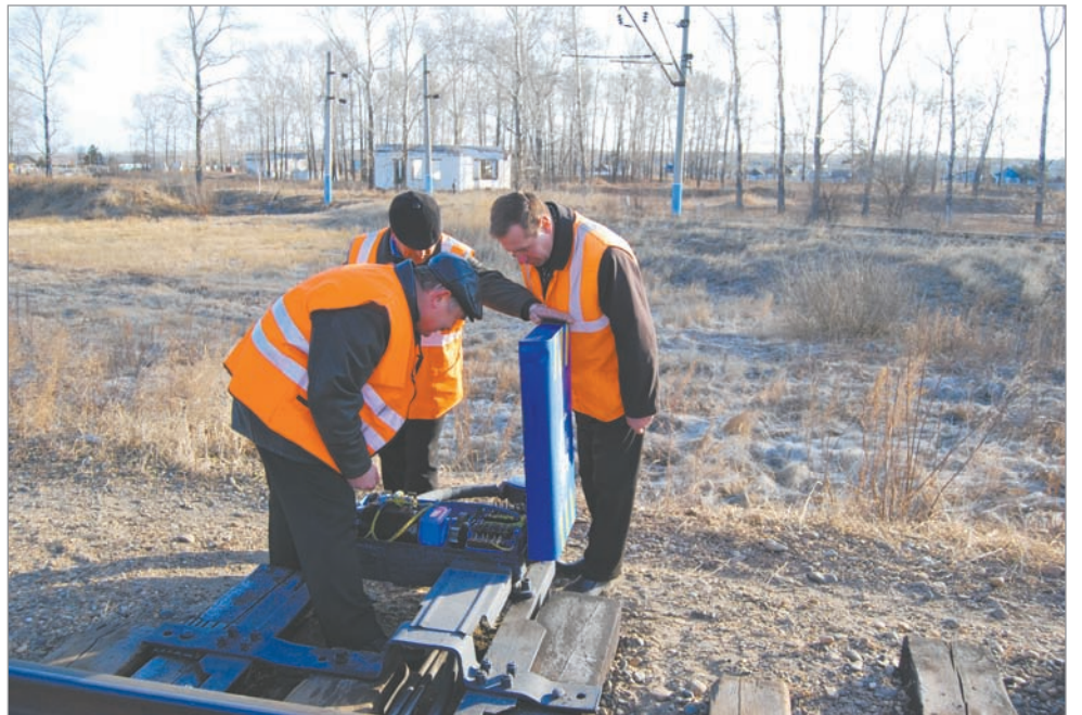
На фото: начальник дистанции централизации и блокировки Белогорск Евгений Цура и заместитель начальника свободненского отдела дирекции инфраструктуры Николай Киселев проверяют состояние электропривода стрелочного перевода.
