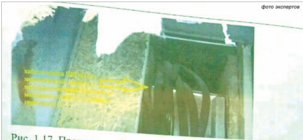
Рис. 1.17. Прокладка кабелей в квартире №16 в полости стен
