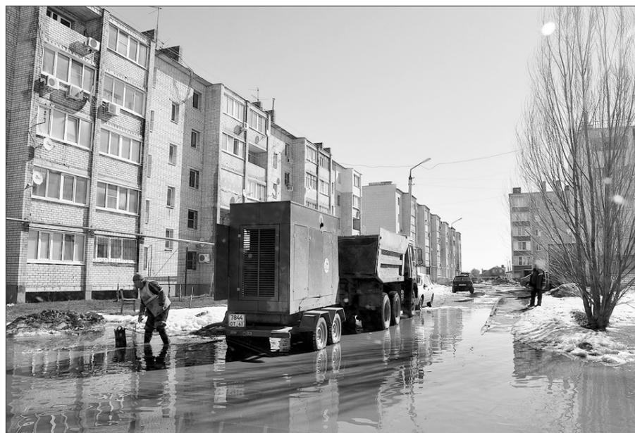
**Улица Фестивальная. Ведутся работы по откачке талой воды с применением дизельной станции и погружного глубинного насоса. Мощность откачивающего устройства - около одной тысячи литров воды за одну минуту.**
