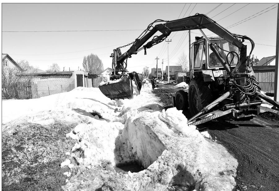
**Вскрытие от снега водоотводного кювета для пропуска талых и дождевых вод на улице Вилюновская.**
