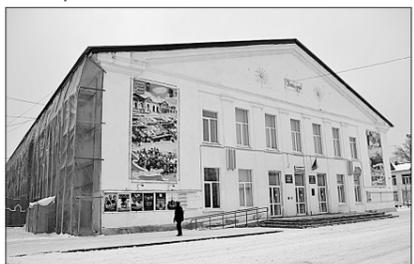
Постепенно фасад покрывают «шубой» из бетонного раствора. После проведения необходимых отделочных работ приступят к покраске. Цветовое решение уже определено. Фасад приобретет светло-зеленый оттенок.
