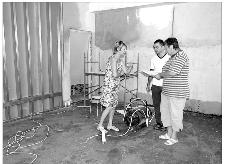
Ремонтные мероприятия каждого этапа работ администрация детского сада «Сказка» обсуждает с представителями подрядной организации.
