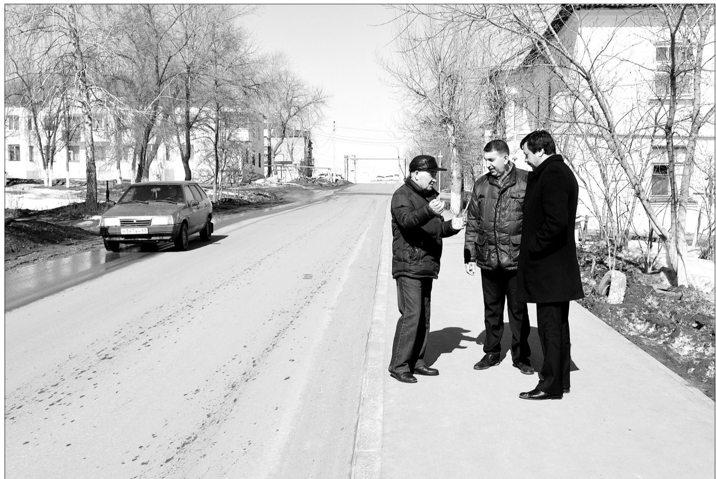
В ходе проверки в поселке Алексеевка инспекторы выявили ряд дефектов на отремонтированной в прошлом году дороге. Претензия на их устранение будет направлена в подрядную организацию.
