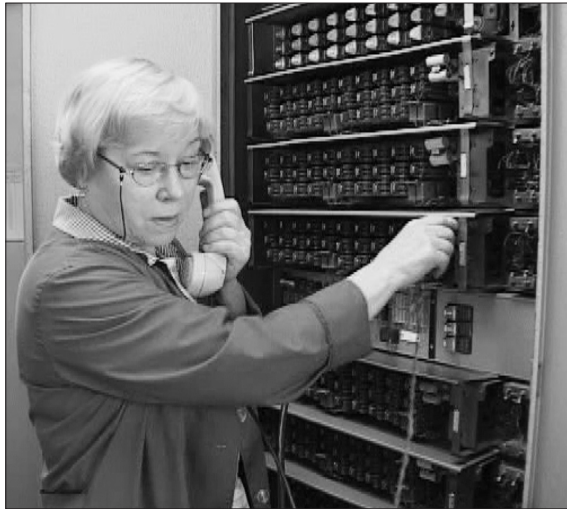
Проверка работы телефонной связи.
