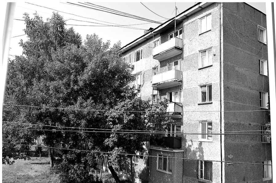
Общественная палата взяла под свой контроль ход подготовки к отопительному сезону ответственными службами. Важная задача всей работы - не допустить в жилом фонде и на объектах социальной сферы проблем минувшей зимы.
