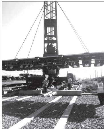
Осень-2017. Установка замедлителей на четной горке.
