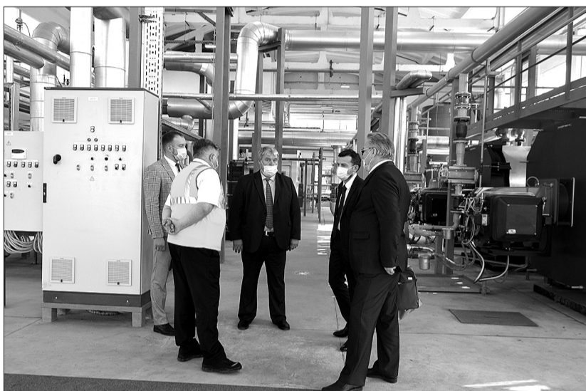
Энергоёмкость установленного оборудования в несколько раз выше, чем в прежних паровых котлах.
