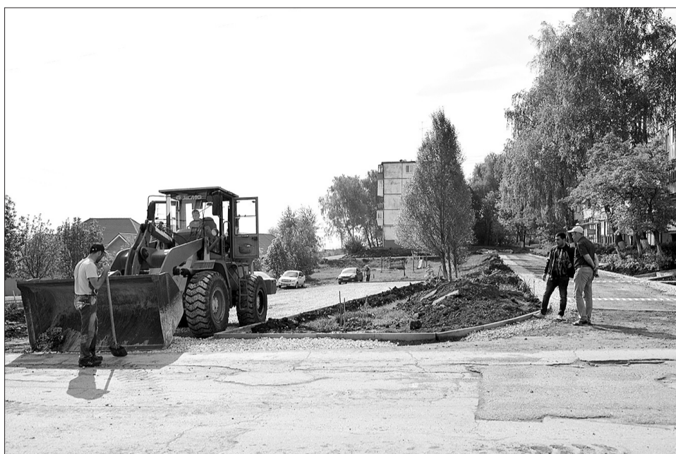
Даже при проведении ремонтных работ видно, как меняются дворы.
