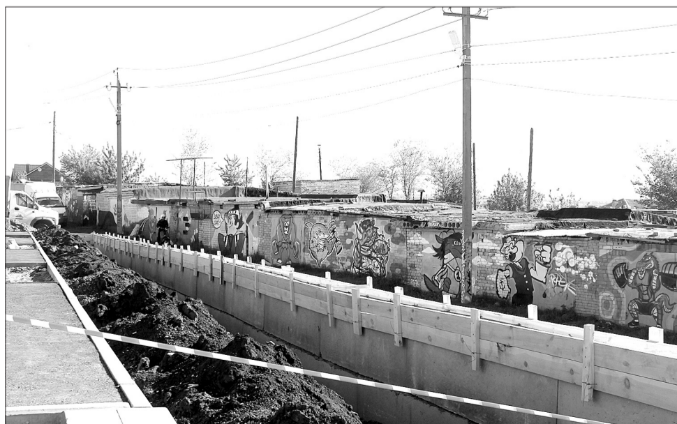
Художественные изображения выполнены по всей стороне строящегося спортивно-игрового комплекса.
