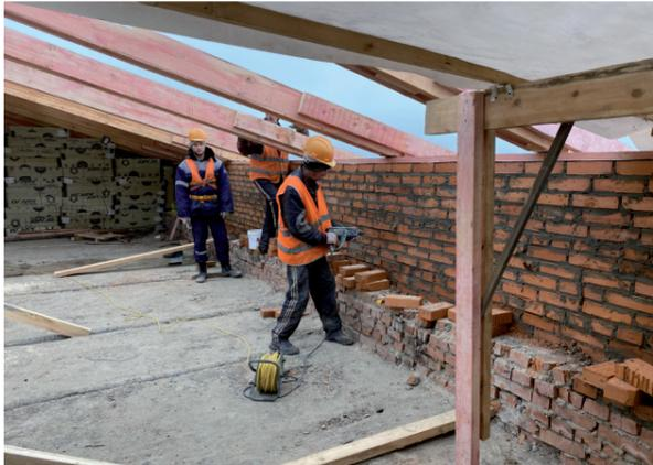
Сейчас мы занимаемся устройством кровельной системы, - пояснил мастер производства работ Сергей Александрович Акамов. - Первая бригада выполняет монтаж стропильной системы, вторая занимается кирпичной кладкой. После завершения данных работ мы приступим к установке сухопровода пожаротушения и молниезащиты. Всего на данном этапе задействовано 22 человека, и по установленному графику эту часть ремонта мы завершим к 18 декабря.
