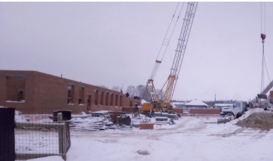
В Горнослинкино продолжается строительство школы на 60 мест.
