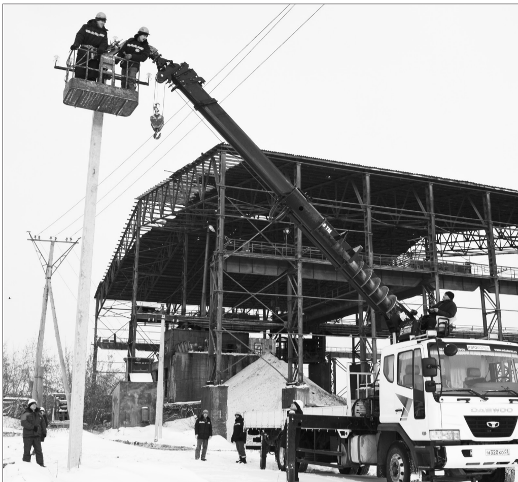
Бригада электромонтёров под руководством начальника энергоцеха Алексея ЛЮТИКОВА и мастера участка Алексея ГЛУХОВЦЕВА меняет опоры на воздушной линии электропередач.
