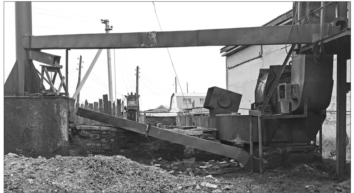
Целое лето котельная в Творогово простояла на замке, так и не дождавшись обслуживающего персонала...
