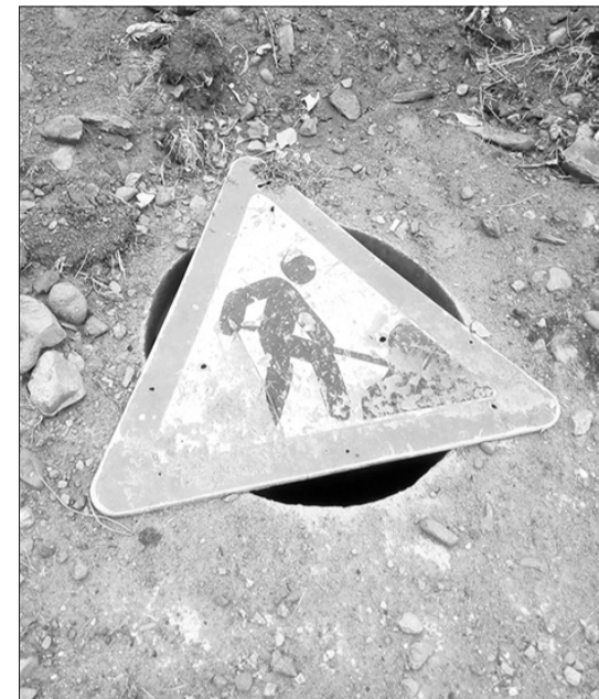
Закончен ремонт теплотрассы в Каменске на улице Комсомольской. Рядом находятся магазины и детская площадка...
