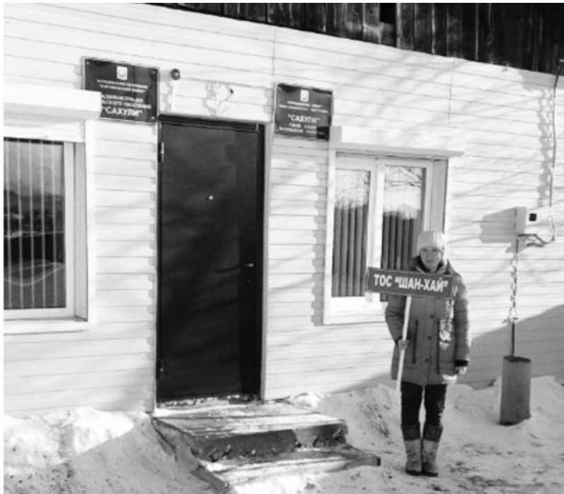
Ремонт здания в селе Сахули
