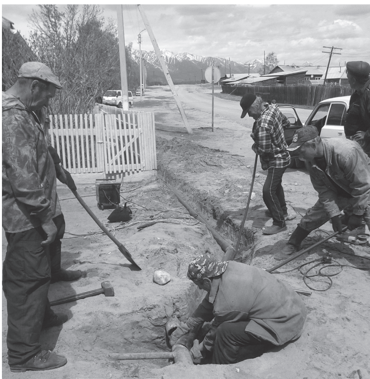
Ремонт летнего водопровода
