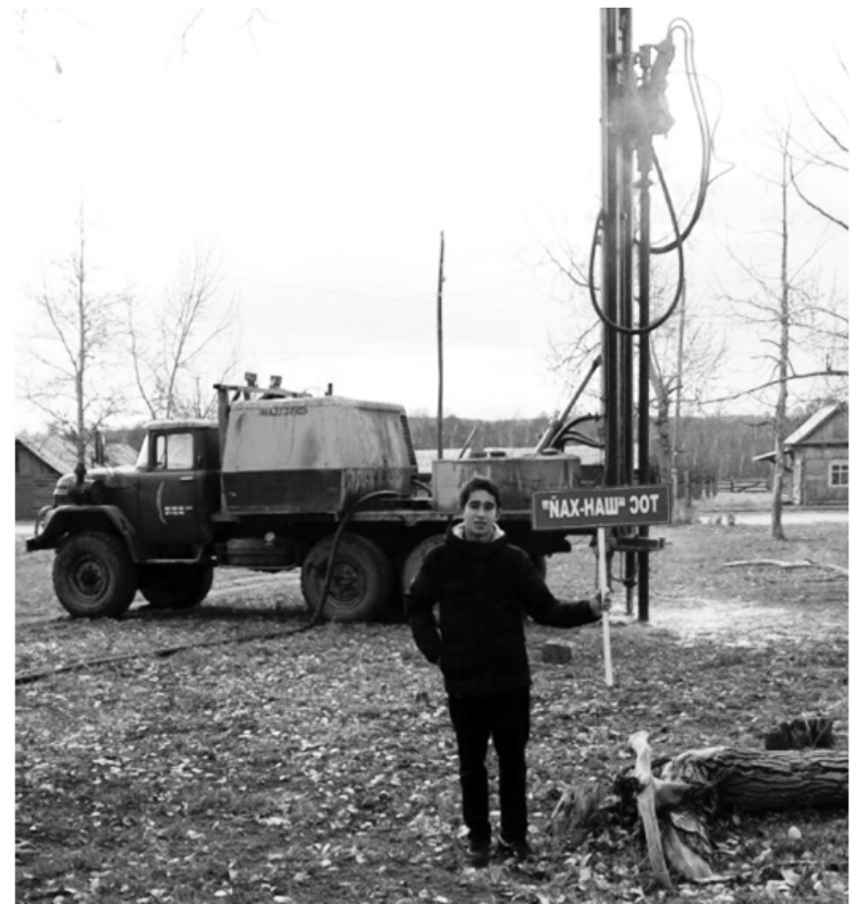
ТОС «Шанхай»: бурение скважины на воду в селе Шаманка
