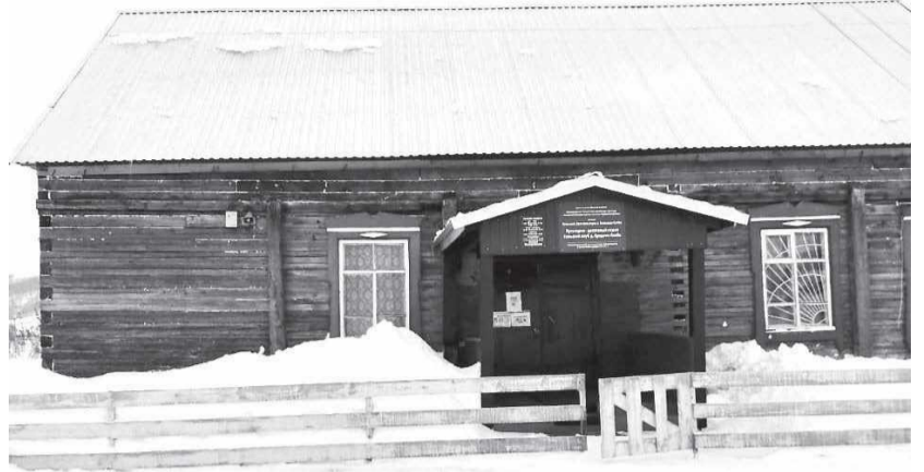
Заменена кровля здания клуба в д. Средней Салбе
