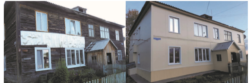
До и после ремонта фасада в г. Туруханске, ул. Строительная, д. 3
