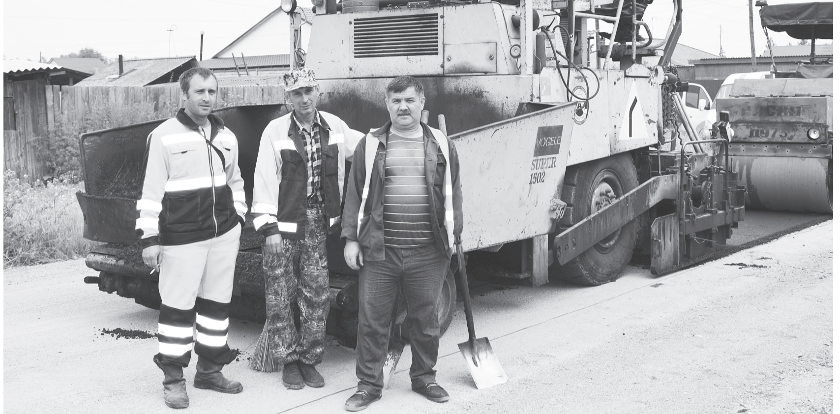
Мастер дорожного участка Николай Скутин (слева) с работниками; они ведут ремонт дороги на улице Молодежной
