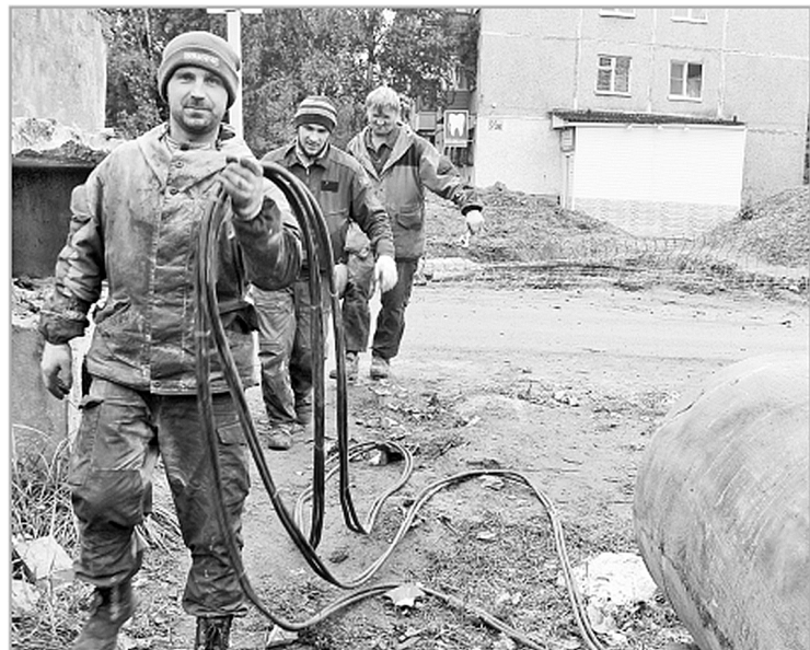
В 15 муниципалитетах провели капремонт 25 объектов ЖКХ
