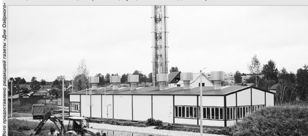
В ЗАТО Озёрный завершены работы по строительству блочно-модульной котельной на 25 МВт
