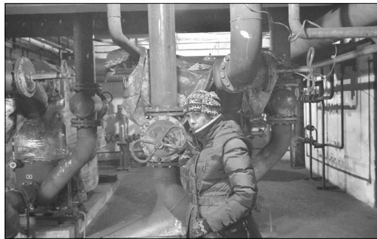
Наши корреспонденты побывали в недостроенной котельной силикатного завода.
