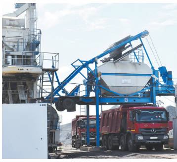
Сколько тонн асфальта в сутки изготавливают в Красном Яре - с. 6
