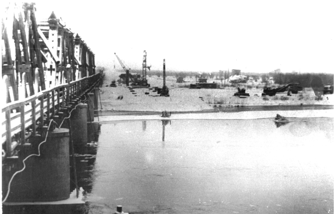
Мост через Онон в период строительства
