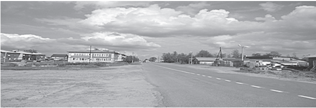
Рисунок 12. Улица Викулова. Отсутствие бордюрного камня, водоотвода с поверхности проезжей части, дефекты покрытия. Требуется обустройство остановок общественного транспорта.
