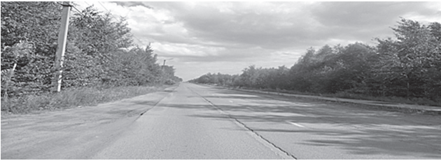
Рисунок 12. Улица Вахская. Отсутствие бордюрного камня, водоотвода с поверхности проезжей части, дефекты покрытия. Требуется обустройство остановок общественного транспорта.
