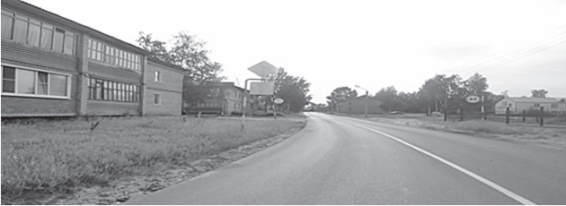
Рисунок 13. Улица Новая. Отсутствие бордюрного камня, водоотвода с поверхности проезжей части, тротуара.
