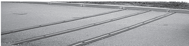
Рисунок 14. Сборная резиновая шумовая полоса
