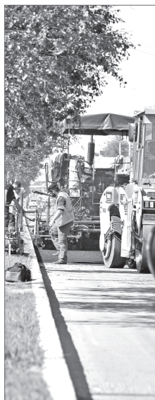
...и ремонт автодорог.
