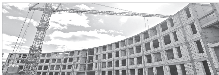
Самые крупные проекты включают строительство в городе Нижневартовске средней общеобразовательной школы на 825 мест...
