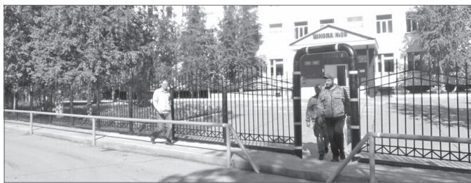
Пока верстался номер, ограждение вдоль тротуара уже смонтировали и даже покрасили.
