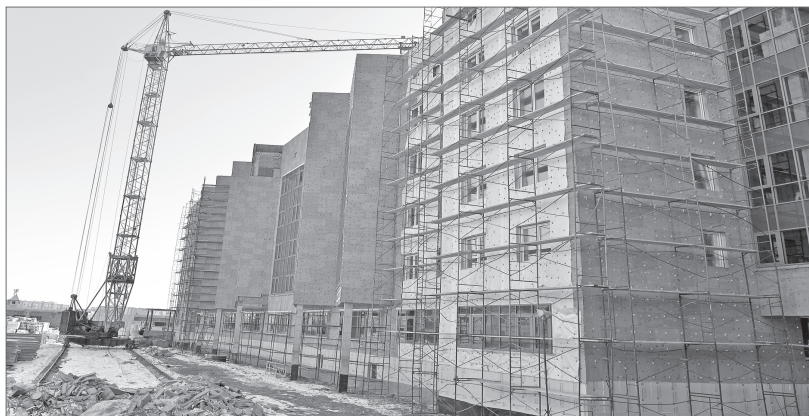
Завершаются работы в блоке «Г».
