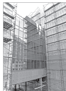
Работа по остеклению в блоке «Б».
