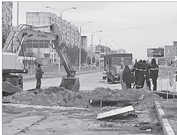
На месте образовавшегося провала потребовалось срочно восстановить коллектор сточных вод.
