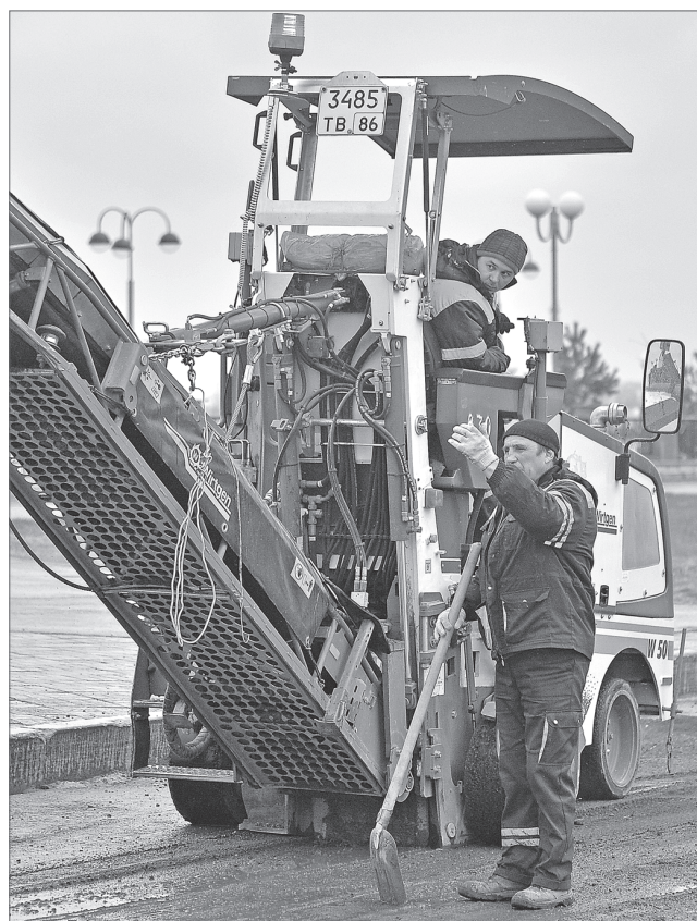
Идет подготовка дорожного полотна на улице Пикмана в районе флаштока.
