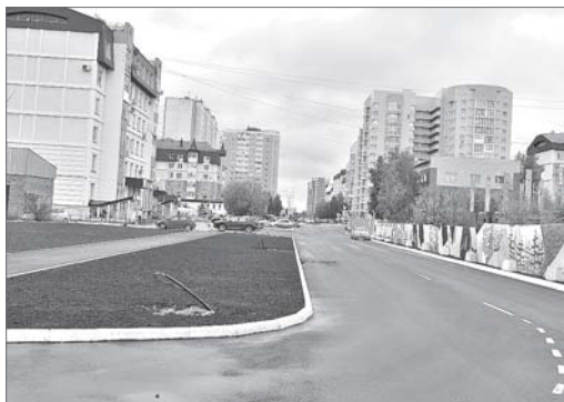
По инициативе членов Общественной палаты был отремонтирован участок дороги в районе дома быта «Кристалл».
