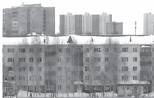
Рисунок 9.7. Пример оформления фасада пятиэтажного дома после капитального ремонта
