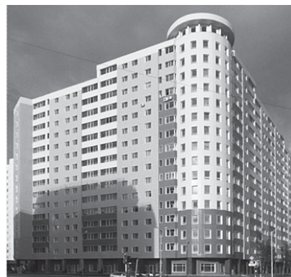
Рисунок 9.18. Существующее здание с отделкой фасада керамогранитными плитами
