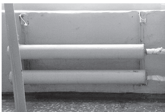
Рисунок 9.10. Мощные регистры вместо небольших отопительных приборов
