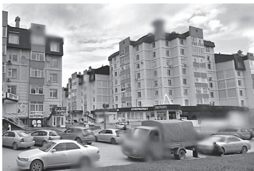
Рисунок 9.6. Выцвела фасадная краска
