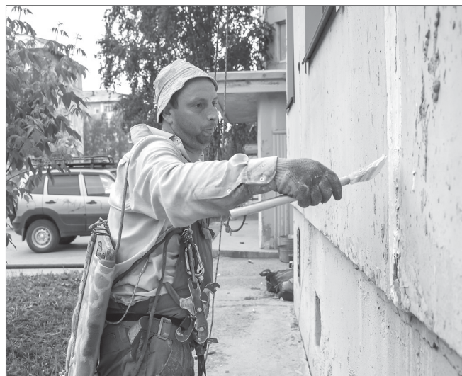
Восстановление межпанельных швов современным герметиком.
