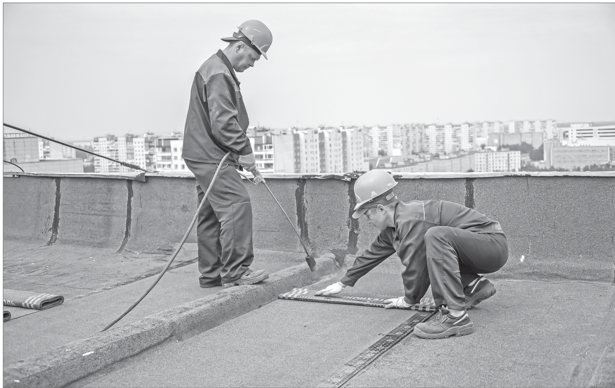
Теперь не страшны кровле косые дожди.
