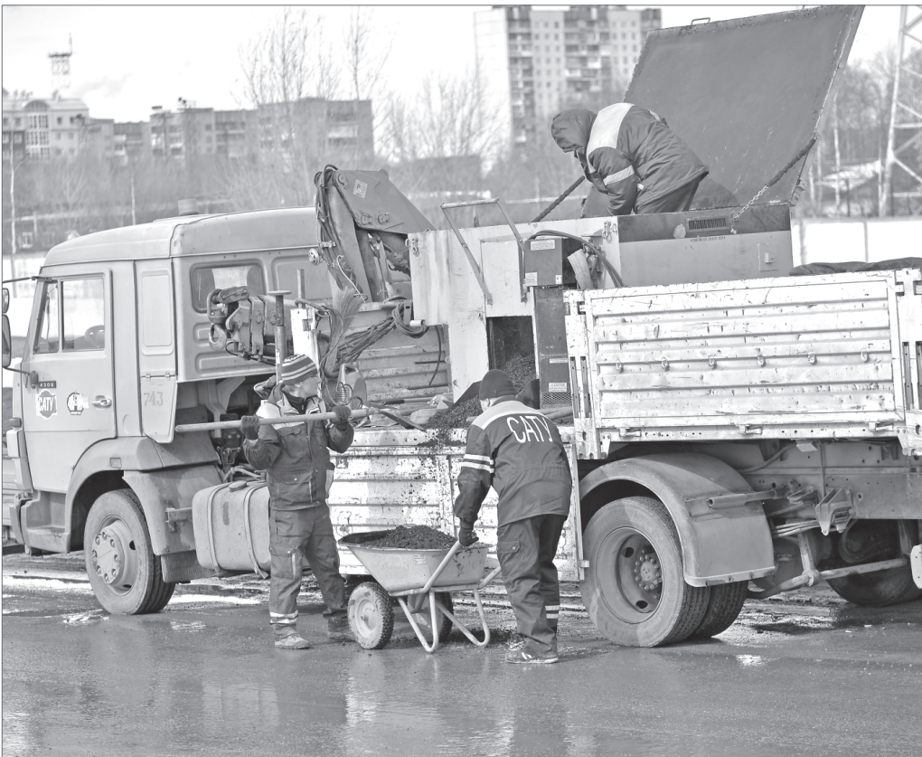
Специалисты САТУ проводят аварийный ремонт проблемных участков дорог с использованием холодного асфальта.
