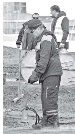
Когда установится теплая погода и заработают асфальтобетонные заводы, дорожники приступят к полноценному ямочному ремонту, сплошному асфальтированию.
