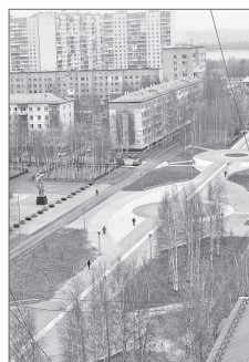
Комсомольский бульвар после реконструкции.
