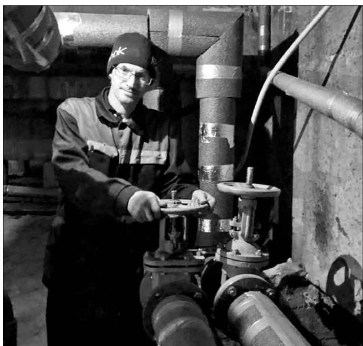
Евгений Туранов, слесарь-сантехник 5 разряда УК «Диалог», открывает подачу теплоносителя.
