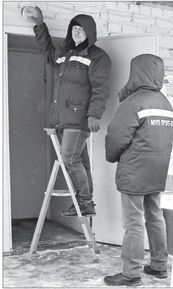
Электрик 6 мкр Евгений Маликов внимательно следит за освещением в жилых домах.
