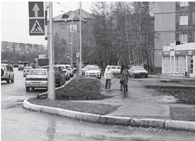
Рисунок 12.1. Примеры некачественных съездов на пешеходные переходы автомобильных дорог
