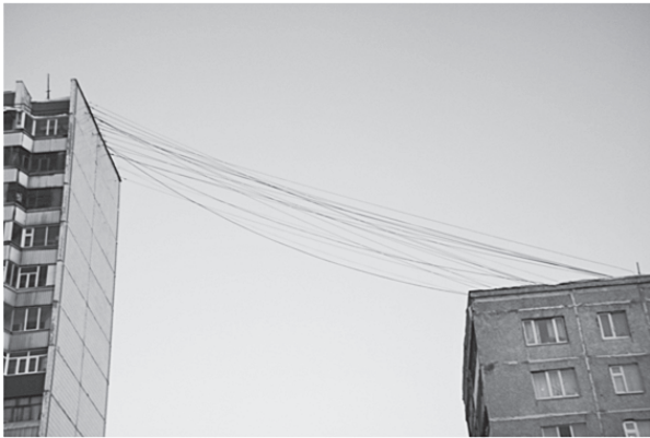
Рисунок 11.3. Кабельные линии сетей связи, проложенные воздушным путем от дома к дому
