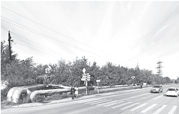
Рисунок 11.5. Улица Кузоваткина до реконструкции сетей теплоснабжения
