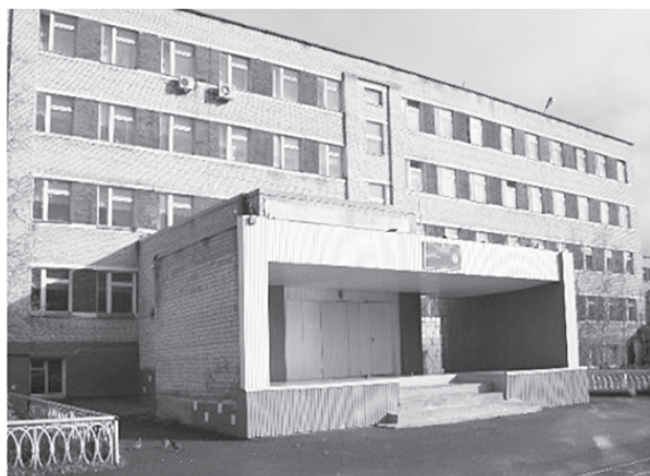
Рисунок 13.1. Пример отделки фасада школы
