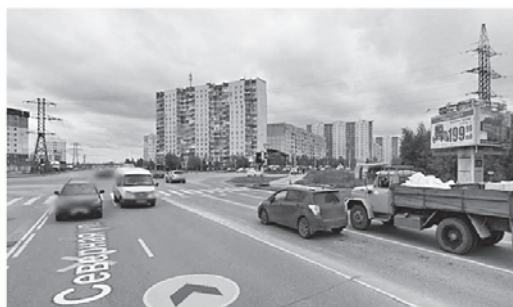
Рисунок 11.2. Электрические высоковольтные сети, расположенные по улице Северной вдоль 10В микрорайона
