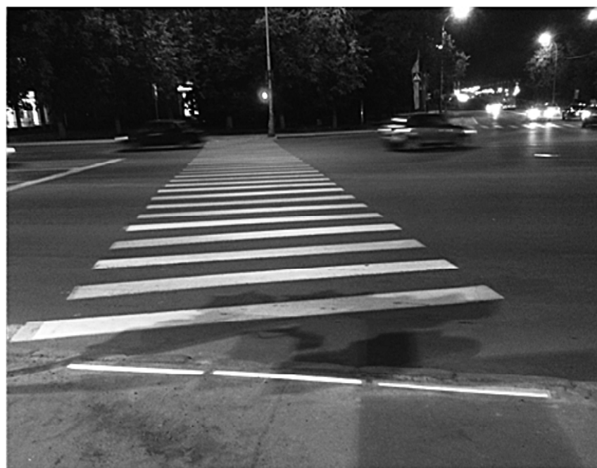
Рисунок 3.14. Пример установки лазерного указателя, проецируемого на пешеходный переход перед дорогой
