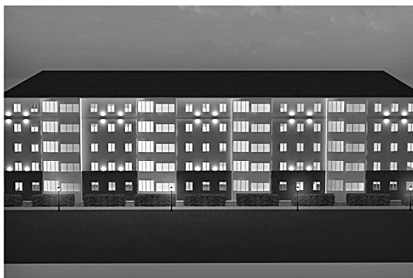
Рисунок 5.15. Освещение фасада пятиэтажного дома, ориентированного на улично-дорожную сеть города
