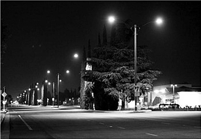
Рисунок 5.8. Освещение после замены на светодиодные светильники
