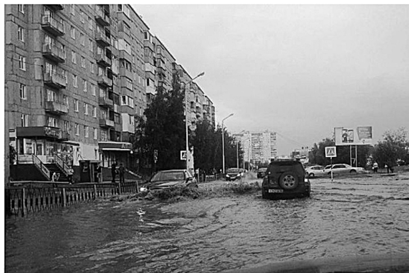
Рисунок 2.4. Отсутствие водоотвода
