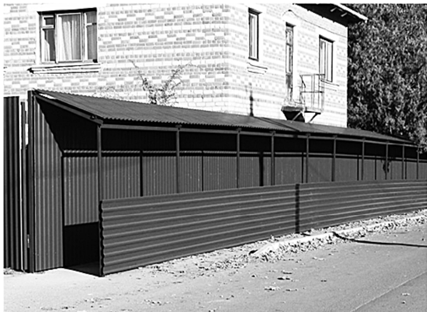
Рисунок 3.15. Пример ограждения строительных площадок
