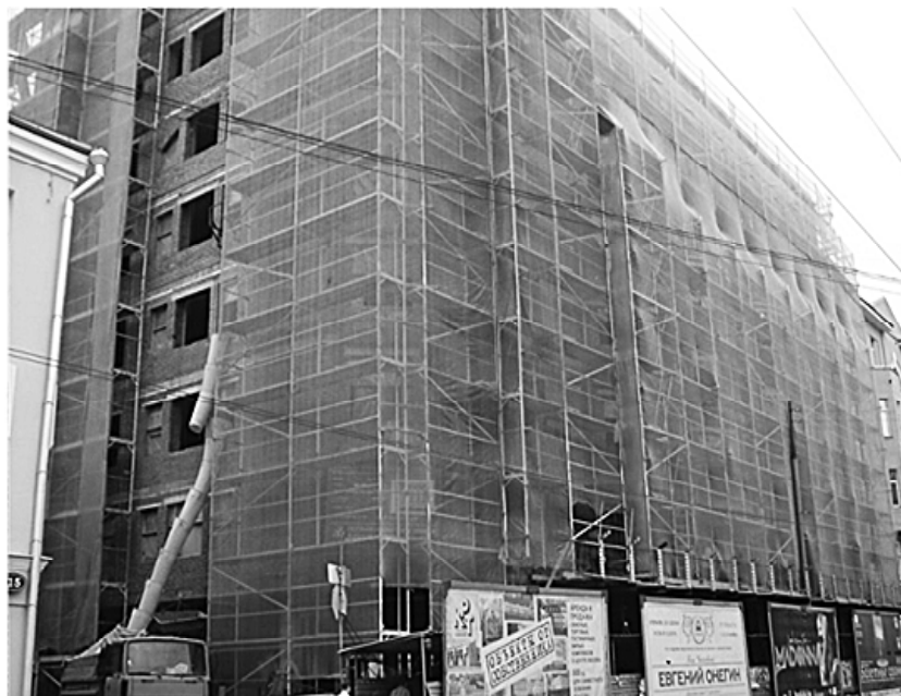
Рисунок 3.16. Пример установки защитной сетки
