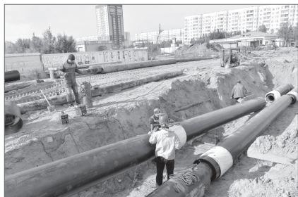
Модернизация теплосетей в Восточном планировочном районе. С ее помощью десятки новых домов смогут получить отопление.
