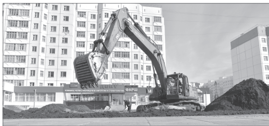
На продолжении улицы Мира за Ханты-Мансийской вовсю кипит работа. Строители должны сдать ее до 1 октября.
