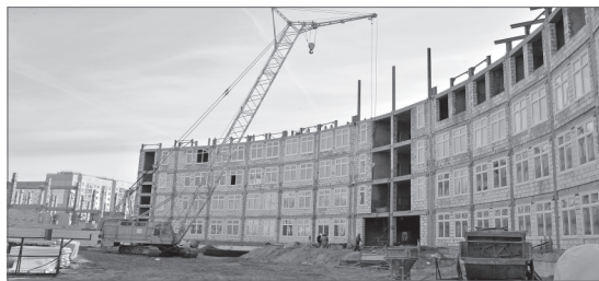
Новая школа в 18 мкр. Первую очередь строительства должны сдать в 2019 г.
