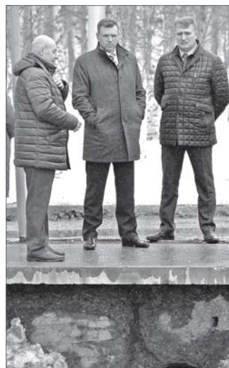
Руководители оценивают качество очистки ливневых канализаций.
