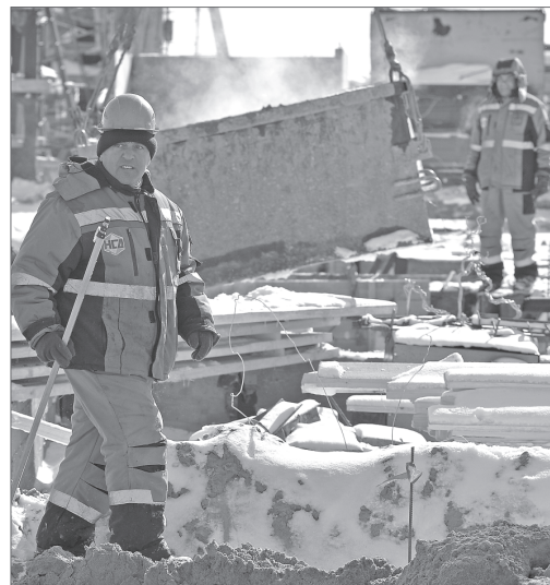
Бригада плотника Мусина Кафарова занимается укладкой фундамента многоэтажек.
