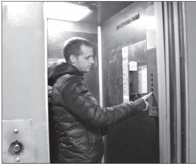
ла осуществлена замена 44 лифтов.
