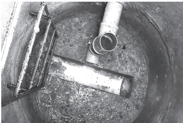
Новый канализационный колодец у д. №13 мкр. Чёрная Речка
