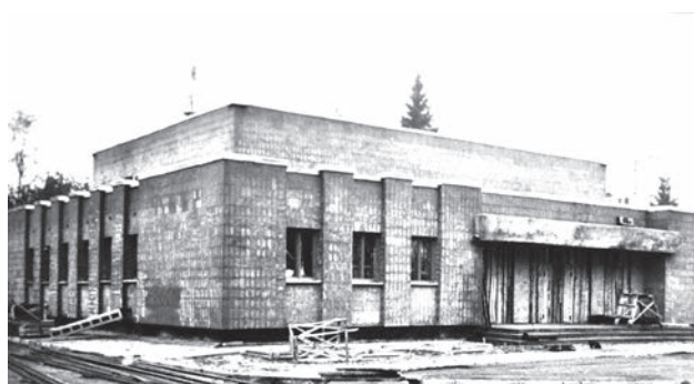
ЗАКАНЧИВАЕТСЯ СТРОИТЕЛЬСТВО ДУШЕВОГО ПАВИЛЬОНА
