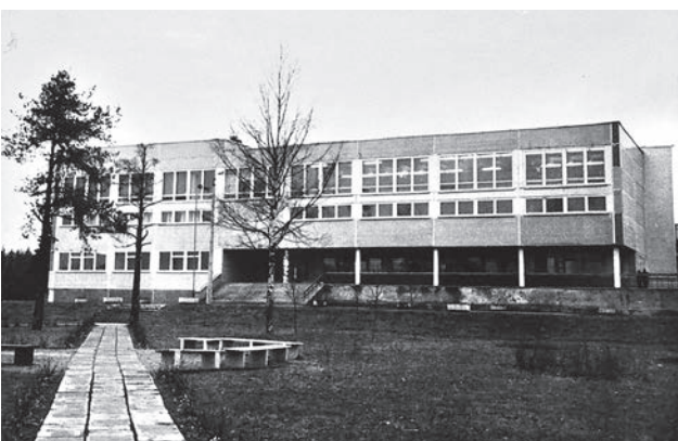
НОВОЕ ЗДАНИЕ СЕРДОВСКОЙ ШКОЛЫ
