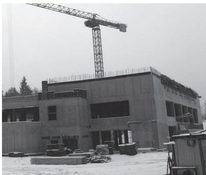
Как сообщила пресс-служба губернатора и Правительства Ленинградской области, на сегодня завершены работы по устройству и гидроизоляции фундаментной плиты, по устройству стен, колонн и лестниц подвала и первого этажа, монтаж балластных резервуаров.
